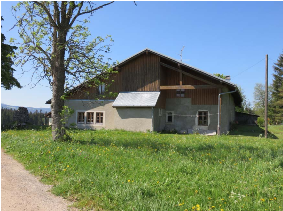
f) Le Grand voisinage de la Frasse, partie de bise et façade de bise.
