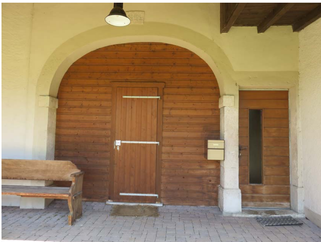
Détail de la porte de grange et de la porte d'entrée.
